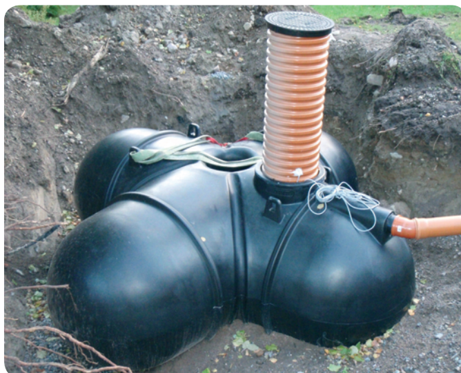
Installation av sluten tank 3000 L PE
