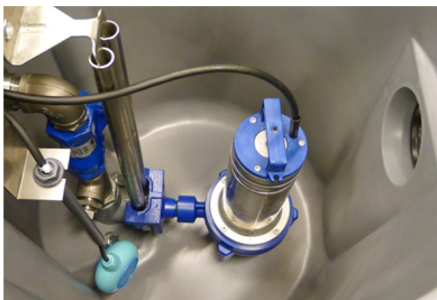
Pumpstationen är utrustad med gejdör för enkel inspektion av pumparna.
