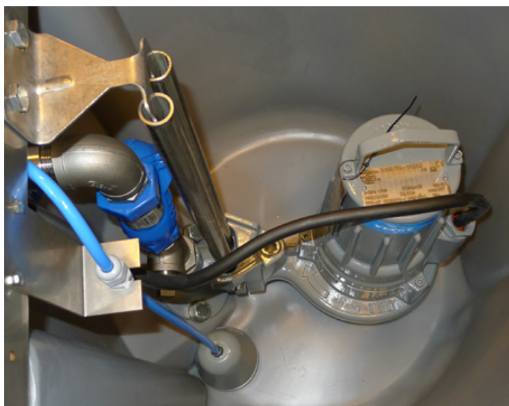
Pumpstationen är utrustad med gejdorr för enkel inspektion av pumparna.
